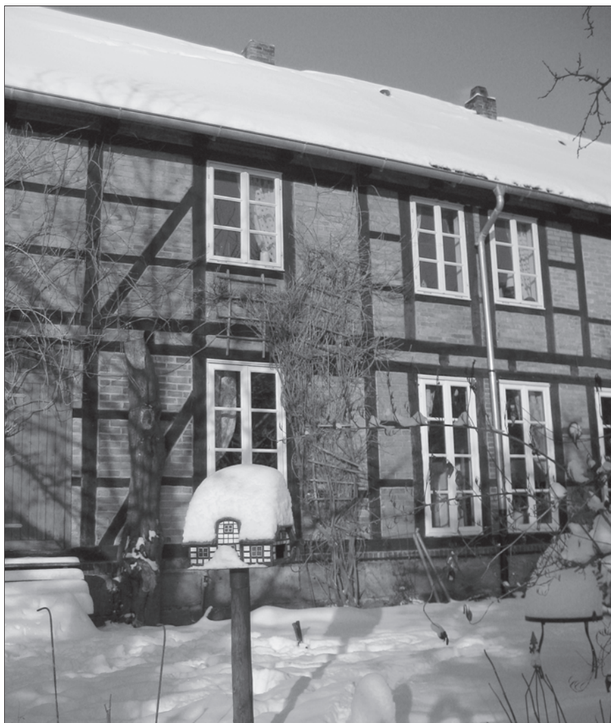
Die Schneelast auf dem Dach ist der Beweis: Die alten Flaschenkorken auf dem Dachboden dämmen gut! Foto: Dr. Matthias Franke
