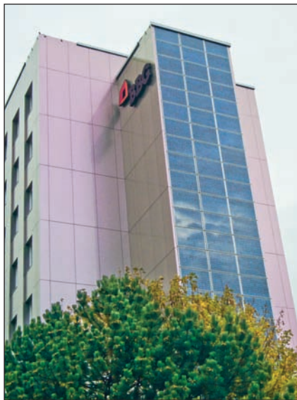
Eine Solarfassade ziert das Hauptgebäude der Braunschweiger Baugenossenschaft. Neben dieser Art der Stromgewinnung ist es sinnvoll, Wohnhäuser energetisch zu sanieren – sie nicht nur gut und nachhaltig zu dämmen, sondern auch die anderen Verbräuche zu reduzieren.
