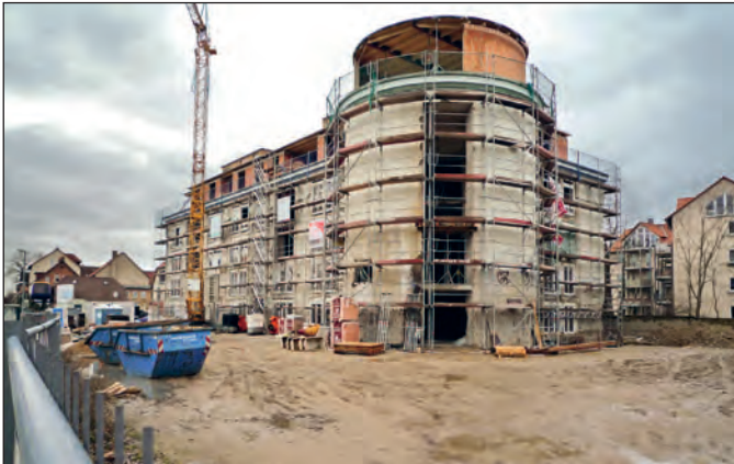
Mag der Umbau einstiger Bunker in Wohnungen auch grundsätzlich sinnvoll sein – der Bau am Madamenweg stört dennoch das Ensemble der Straße.
