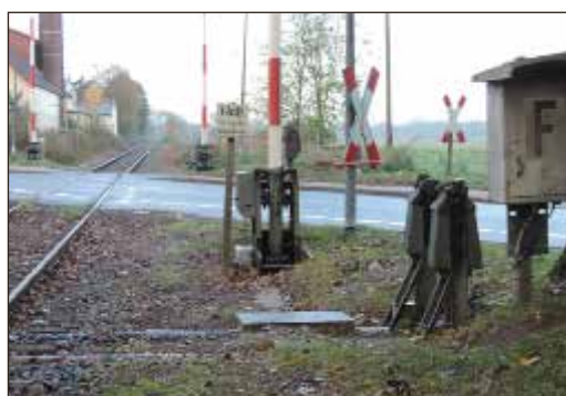
An der Peiner Straße hält der Müllzug, dann wird die Schranke heruntergekurbelt, der Müllzug fährt durch, hält wieder, die Schranke wird hochgekurbelt und weiter geht's. Der Spargelexpress wird dieser Form Eisenbahn-Romantik ein Ende setzen.
