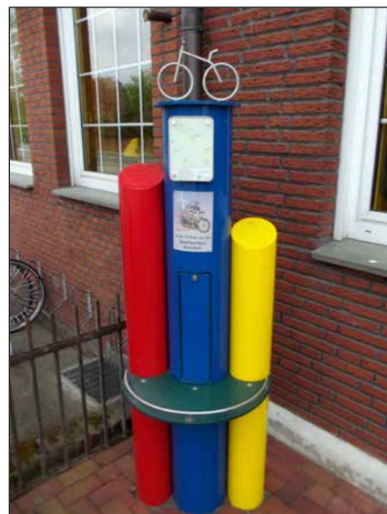
Auch Elektrofahräder brauchen „Tankstellen“, hier eine sehr schön gestaltete. Foto: Nordhorner II, wikipedia
