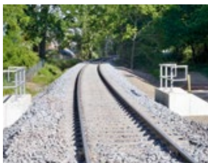
Auch dieser Bachdurchlass ist 2015 neu erbaut worden – Teil der 23,3 Millionen?
