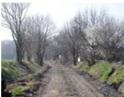
Im April 2015 wurde das Gleis bei Wendeburg grunderneuert.
