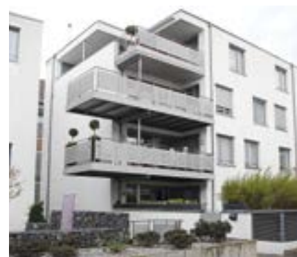
Nachverdichtung in der Echternstraße: Geschosswohnen in Anlehnung an mittelalterliche Gassen, mit verdichteten Wohnungen und viel Grünräumen. Fotos (2): Leonhard Prötzel
