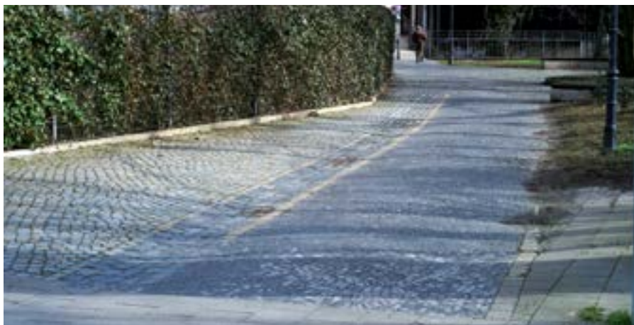
Vier verschiedene Pflaster auf wenigen Quadratmetern, wozu soll das gut sein?
