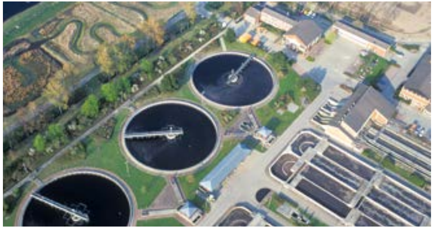
Die Kläranlage in Braunschweig-Steinhof reinigt das Braunschweiger Abwasser, das Mikroplastik kann sie nicht abbauen. Unten rechts die Belebtschlammbecken.
