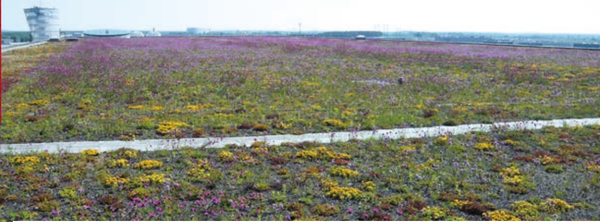
Extensives Gründach mit einer Gesamtgröße von rund 8.600 m 2 am Flughafen Berlin-Brandenburg.
