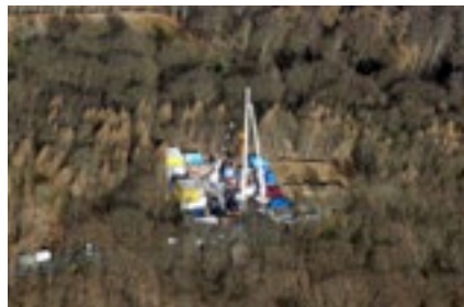
Hat inzwischen das Salz erreicht: die Schachtvorbohrung ASSE V. Foto: ASSE-II-Begleitgruppe
