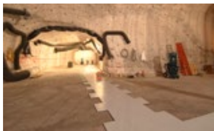
Dekontaminierbare Bodenplatten liegen zur Vorbereitung der Bohrarbeiten vor Einlagerungskammer 7.
