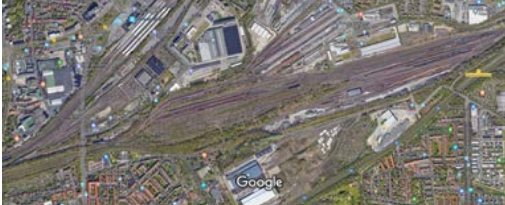
Luftaufnahme des zukünftigen Stadtteils „Bahnstadt“. FOTO: GOOGLE EARTH
