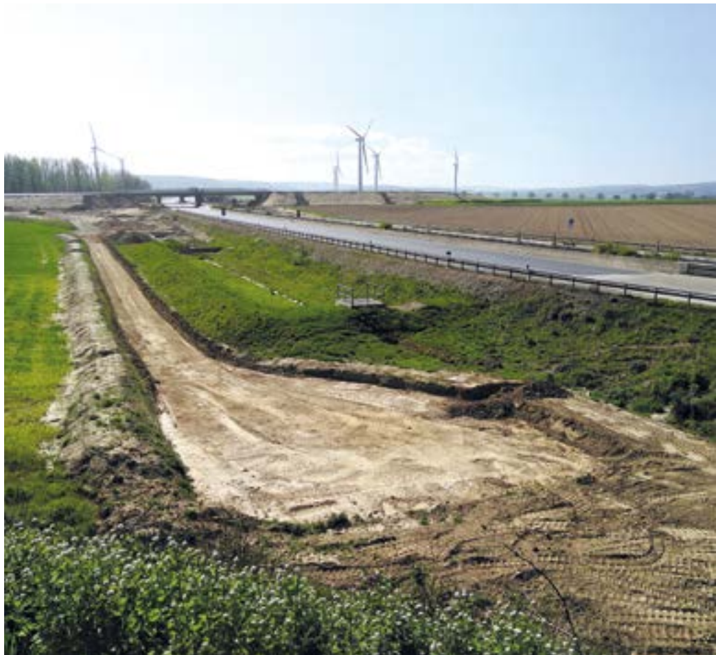
Verlust von Agrarfläche hat viele Ursachen. Straßenbau ist eine davon, wie hier am Autobahndreieck Salzgitter.
