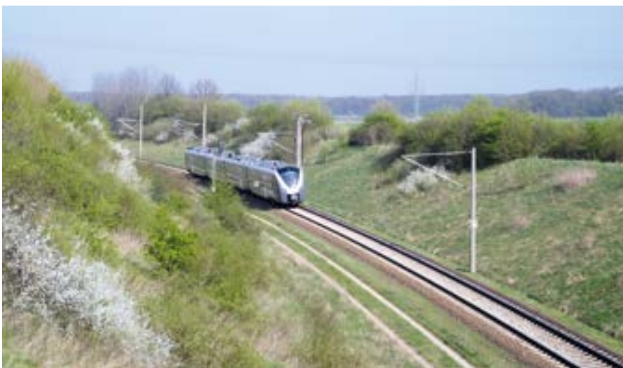
Im Herbst 2021 soll hier das zweite Gleis verlegt werden, dann fallen die Engpässe für die Züge nach Wolfsburg auf der Weddeler Schleife weg.
