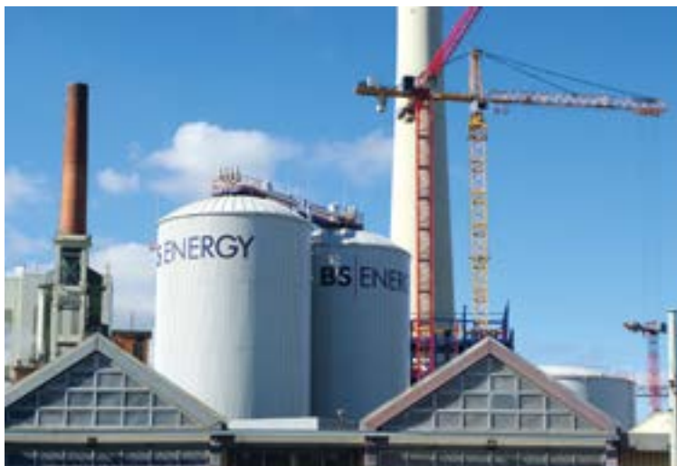
Umbau und Modernisierung des HKW-Mitte an der Hamburger Straße, seit Dezember 2020. Strom und Fernwärme sollen künftig nur noch aus Erdgas und Altholz gewonnen werden.
