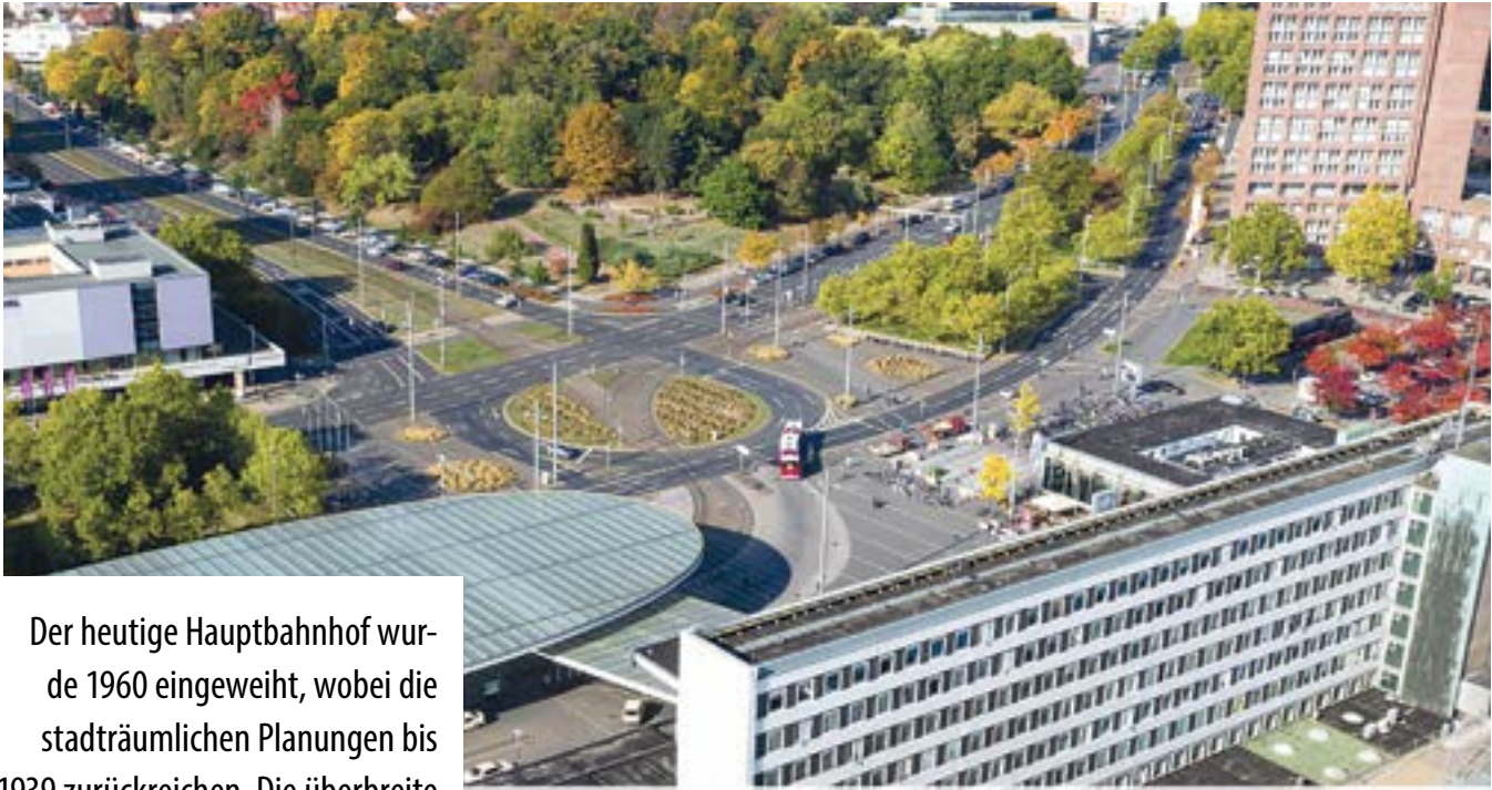
Luftbild Bahnhofsvorplatz. Im Hintergrund der Park Viewegs Garten.
