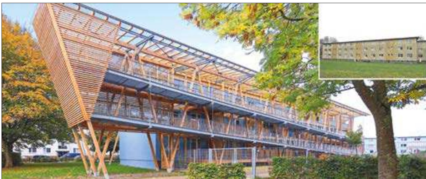
„Spiralhaus“ Ringstraße 36-40 in Bremerhaven-Wulsdorf (STÄWOG) vor und nach der Sanierung.
