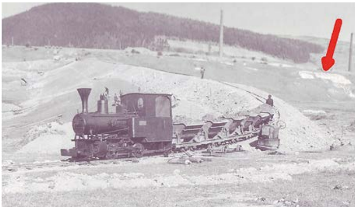
Bau des Sperrdammes am Bollrich, Gelmketal, 1949.
