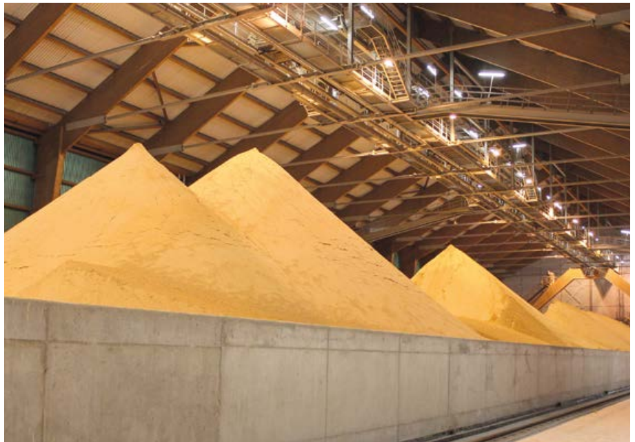
Gipsdepot des Kraftwerks Schwarze Pumpe im Juni 2013. Der bei der Rauchgasentschwefelung als Abfallprodukt anfallende Gips wird von einem benachbarten Betrieb zu Gipskartonplatten verarbeitet.
