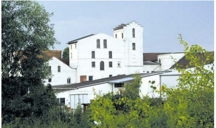
„Krickeroode“ wird die gewässerverschmutzende Fabrik von Wilhelm Raabe genannt. Es handelt sich um die Zuckerfabrik Rautheim. Ein Teil der alten Gebäude von 1864 ist erhalten geblieben, zu finden am Schöppenstedter Turm, Helmstedter Straße, Stadtgrenze Braunschweigs.
