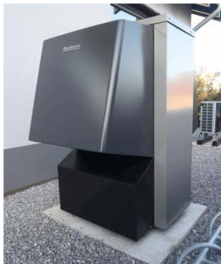
Abb. 8: Luft-Wasser-Wärmepumpe, Logatherm WLW196i AR + mit Schallschutzhaube.
