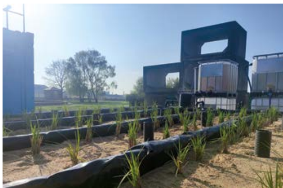
Der bepflanzte Sandfilter soll die restlichen Schadstoffe im Wasser binden und abbauen.
