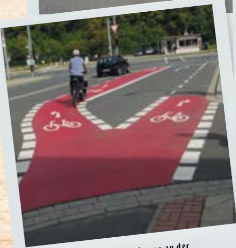
Die schwierige Fahrbahnführung an der Ackerstraße wird für Radfahrer optisch gelöst.
