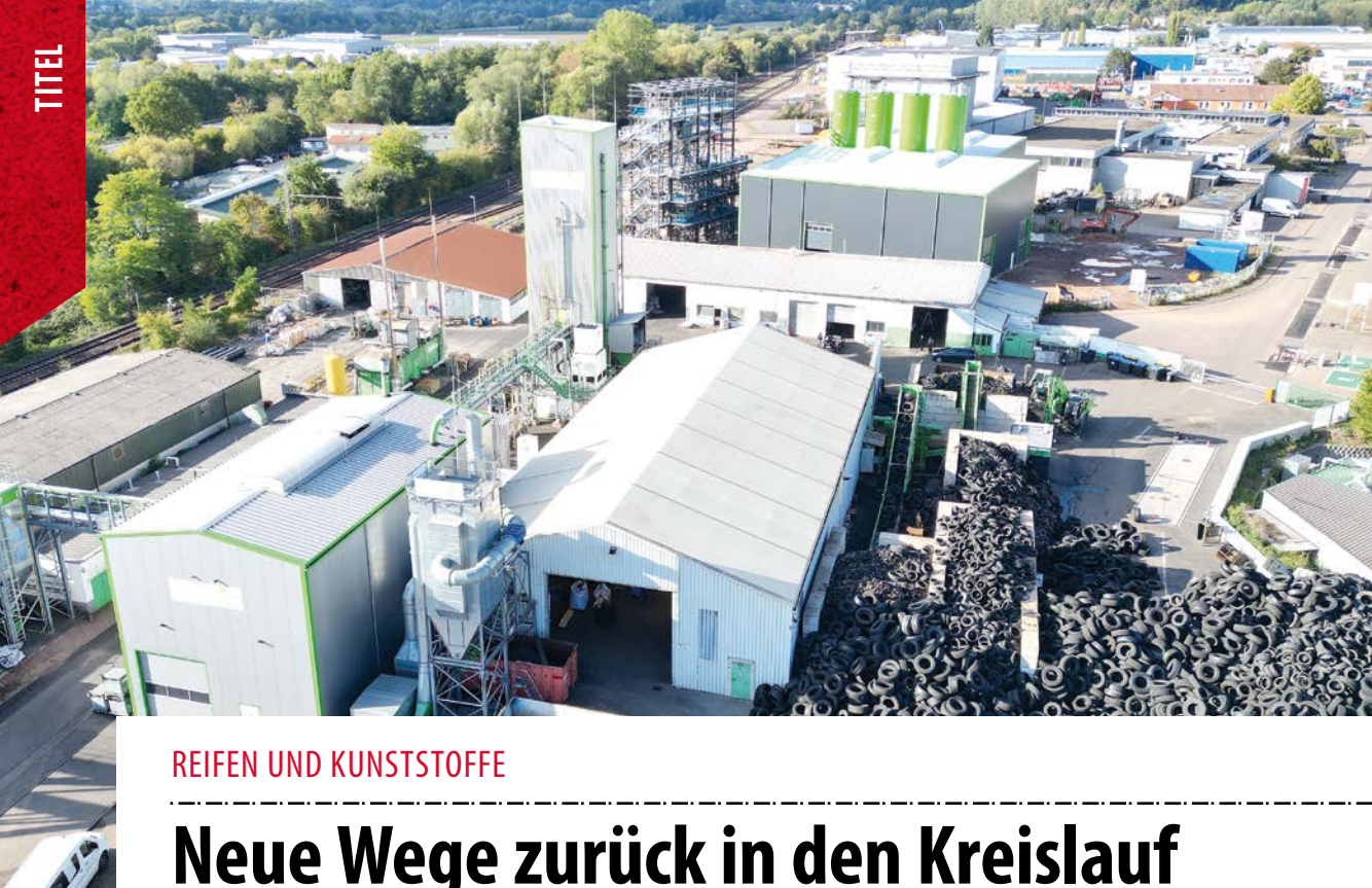
Die erste Anlage der Pyrum Innovations AG in Dillingen/Saar.
