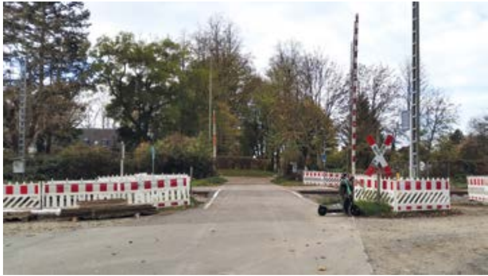
Der Bahnübergang im Grünen soll samt Bäumen im Zuge der Modernisierung des Stellwerks weichen.
