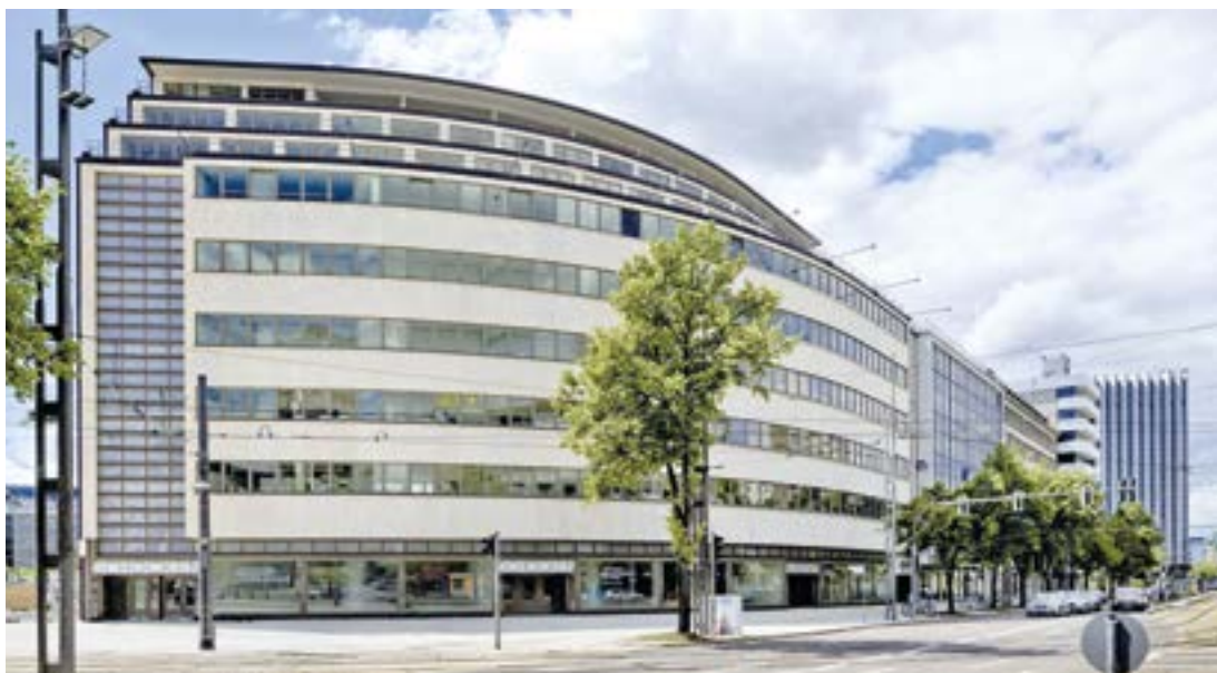
Im ehemaligen Kaufhaus ‚Schocken‘ in Chemnitz, einem von Erich Mendelsohn 1927 konzipierten Warenhaus, befindet sich heute das Staatliche Museum für Archäologie.
