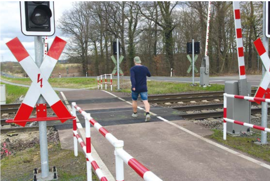
Die Neugestaltung des Bahnübergangs mit einer abgetrennten Furt für Fußgänger und Radfahrer.
