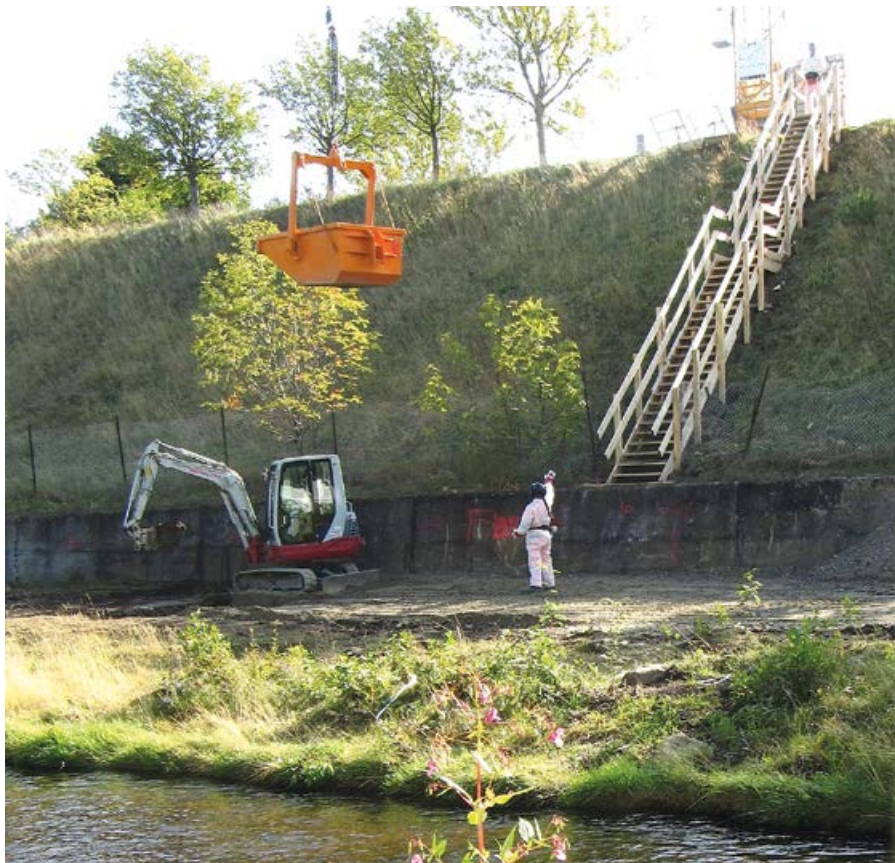
Die Sanierungsarbeiten der Sandbank im Jahr 2014.
